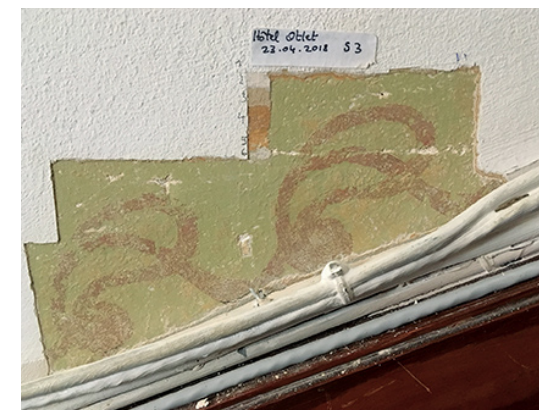
Sondage stratigraphique dans la cage d'escalier. IRPA, 2018.13755
