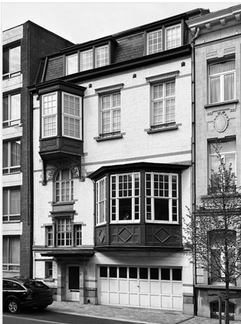
Maison-atelier de Théo Van Rysselberghe, construite par son frère Octave, 63 rue de l'Abbaye à Ixelles [1891-1894].
