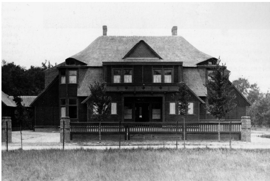
FIG. 26 ABB. H. van de Velde, maison personnelle De Tent , Wassenaar (La Haye), 1920-1921. Construction préfabriquée en bois de la firme silésienne Christoph & Unmack, selon un modèle adapté par van de Velde.
